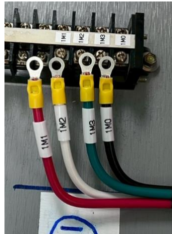
圖 4 壓接時銅線末端超出絕緣套管頂部
